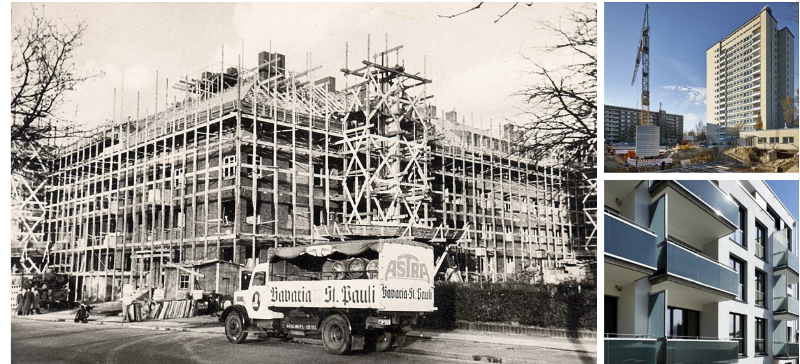
Links: Wie alles begann – der Bau eines Wohnblocks in Barmbek 1924 Oben rechts: Höhe des Krans und Größe der Baugrube machen deutlich, was hier in Farmsen entsteht: Top-Wohneinheiten mit modernstem Standard Unten rechts: Auch der im letzten Jahr fertiggestellte Neubau Flachsland demonstriert nicht nur Moderne und Stilsicherheit, sondern belegt auch die Aktivitäten der BDS FOTOCREDIT: ©MARKUS TOLLHOPF
