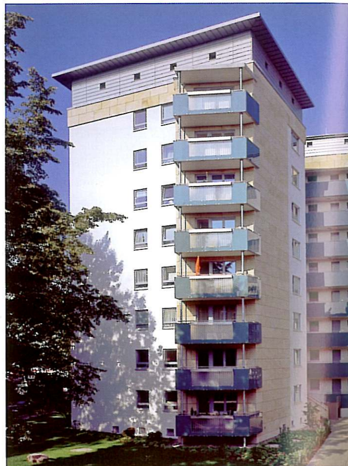
Wohnhaus Klappstraße 11: Alle Freianlagen wurden neu angelegt. Die Versickerungsanlage der Dachflächenentwässerung dient zur natürlichen Bodendurchfeuchtung – ein zusätzlicher ökologischer Beitrag
