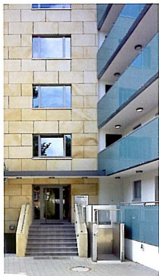
Der Eingangsbereich ist komplett neu gestaltet und mit einem Kleinaufzug barrierefrei ausgestattet
