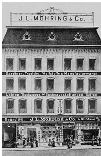
Das 100-jährige Bestehen konnte in den stattlichen Räumen des Geschäftshaus an der ABC-Straße 25 - 27 gefeiert werden.
